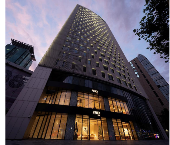
Fendi Casa Store, Shanghai/China
